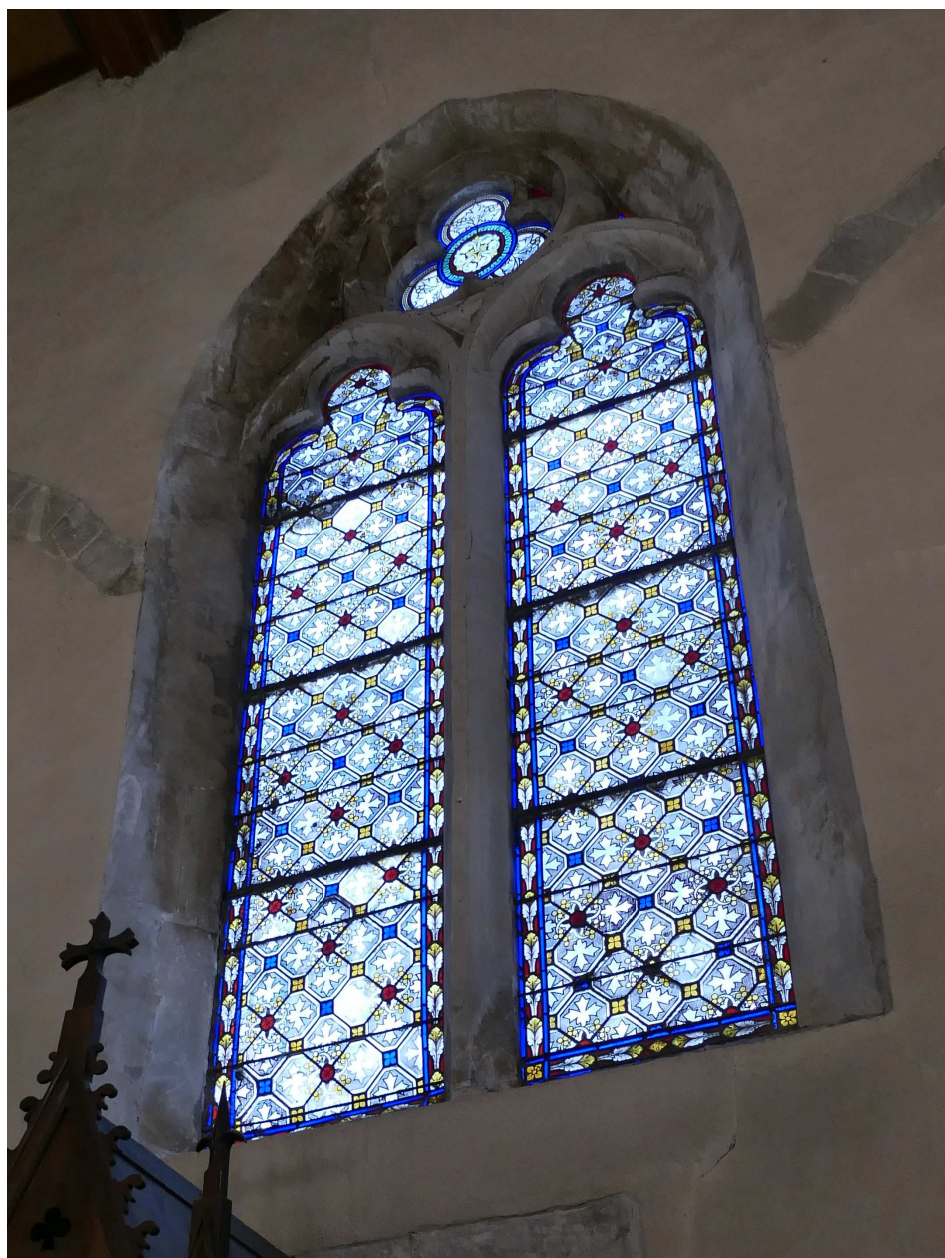
Baie n°6 vue intérieure
